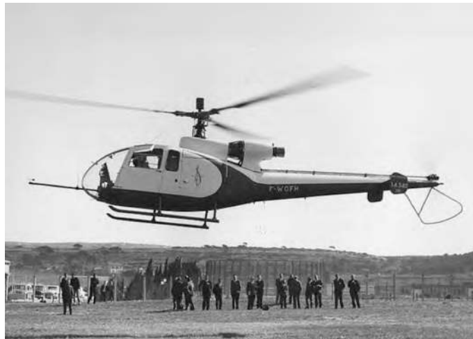
Figure 80 - SA 340-001 avec le rotor anticouple de l'Alouette © Photo DR/Airbus Helicopters
