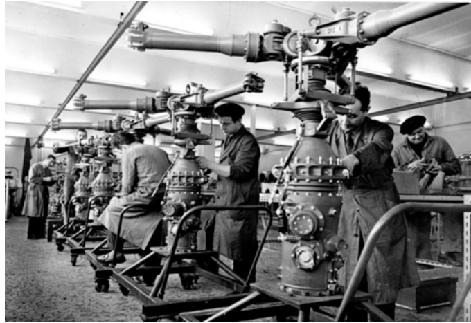
Figure 32 - La Courneuve. Chaîne BTP et moyeu Alouette II © Photo DR/Airbus Helicopters
