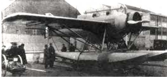
Figure 206 - LeO HY 43, monomoteur à ailes repliables destiné à la Marine nationale...
