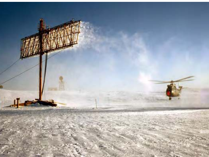
Figure 72 - Essai de givrage devant la grille du NRC à Ottawa (photo CEV)
