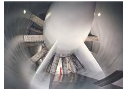
Ventilateurs ( \text{Ø} = 15 \text{ m} , 88 MW)
