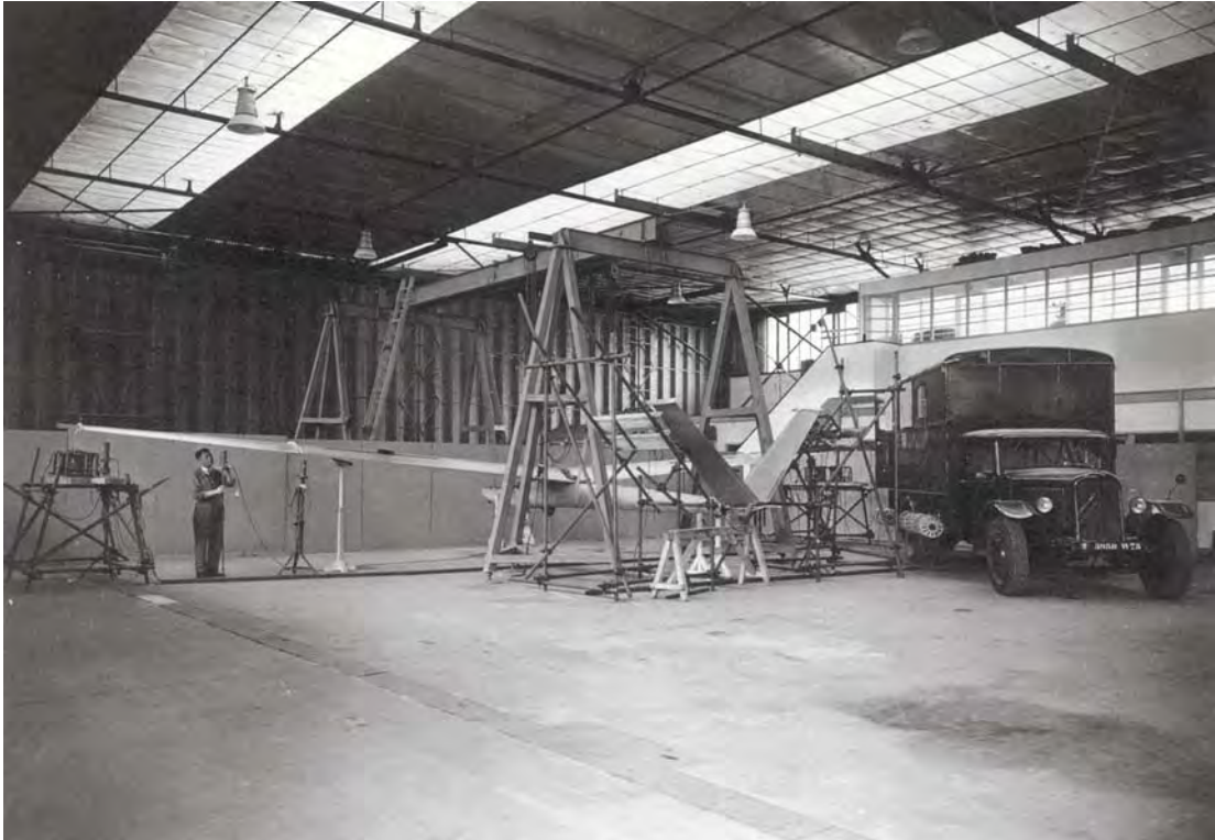
Fig. 80 Première installation mobile d'essais de la SOPEMEA (1956)
