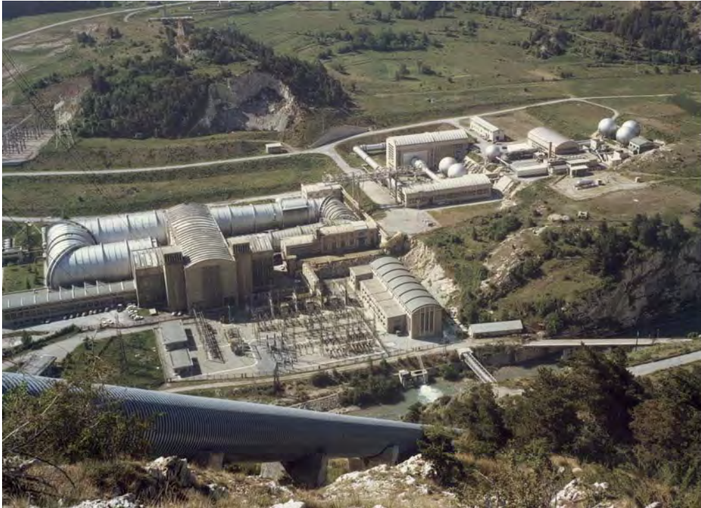
Fig. 13 Les souffleries de Modane. Au premier plan, la conduite d'alimentation des turbines Pelton
