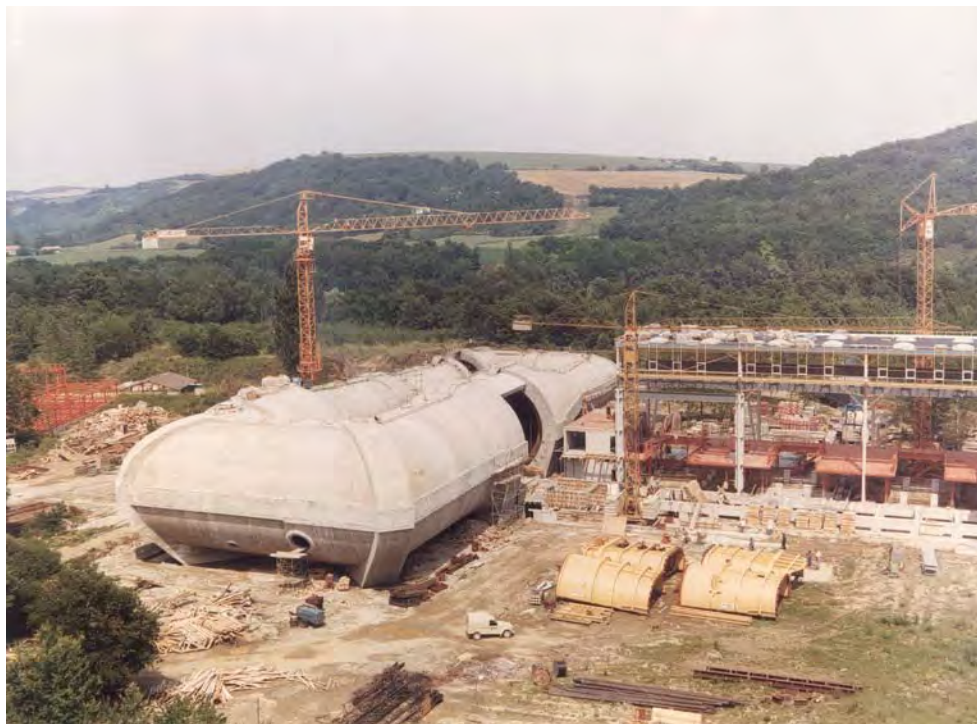
Fig. 53 Soufflerie F1 du Fauga, en construction
