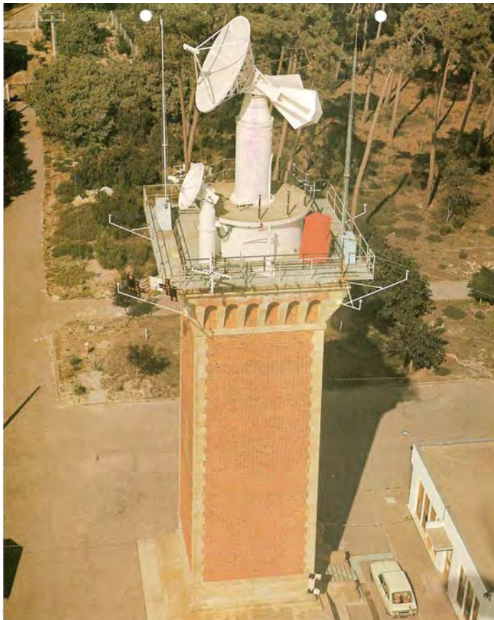
Fig. 16 Le phare désaffecté d'Houert à Hourtin A son sommet, des antennes Antarès. A l'origine, il était coiffé par une antenne Télémaque.
