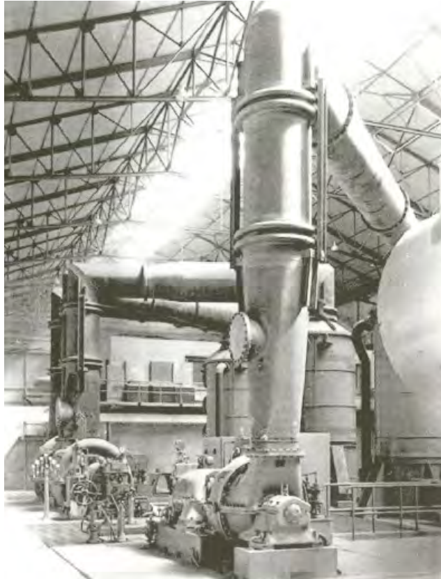
Fig. 9 Groupe d'extraction Rateau (3,5 MW)
