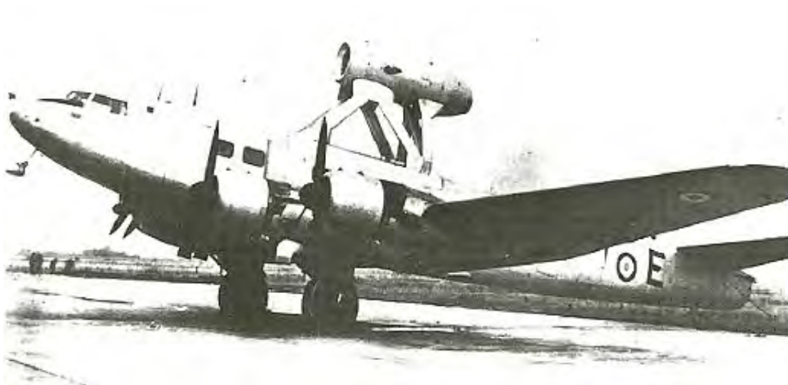
Fig. 2 Banc volant Bloch 161 Languedoc pour essais ATAR
