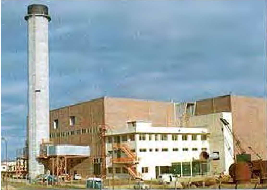
(a) Le Bâtiment C, une imposante installation
