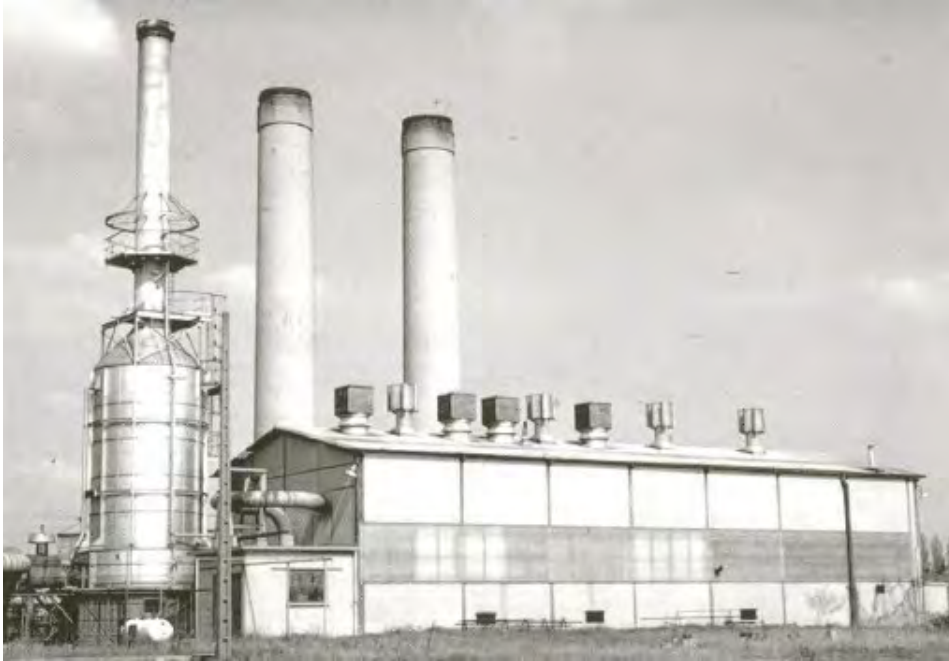
Fig. 7 La chaufferie 2 (chaudières du Montcalm )
