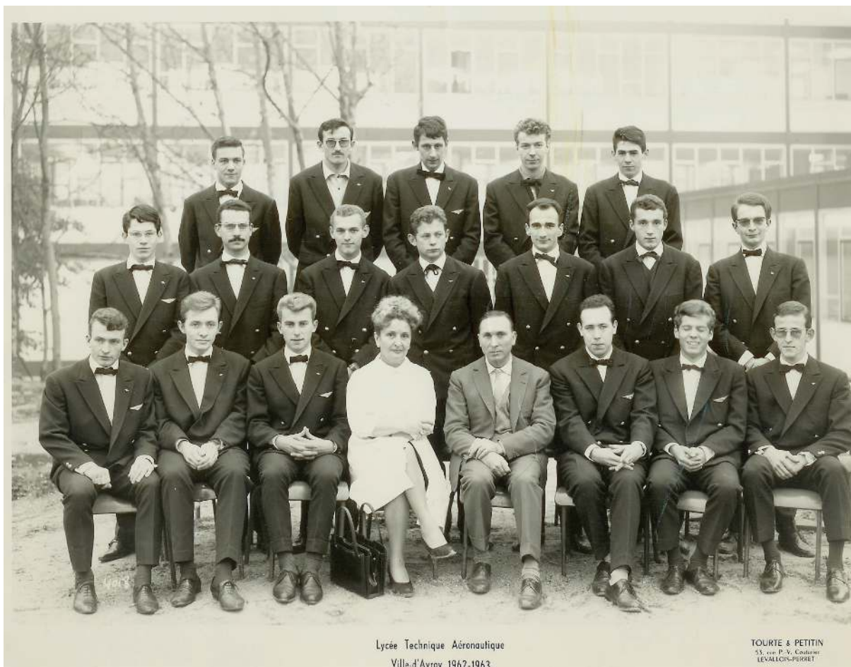
La classe de TS2P à Ville d'Avray , techniciens supérieurs 2 ème année, option propulseur. Au fond, les constructions neuves mises en service à la rentrée de l'année scolaire 62/63. (Source JP Tasseau)
