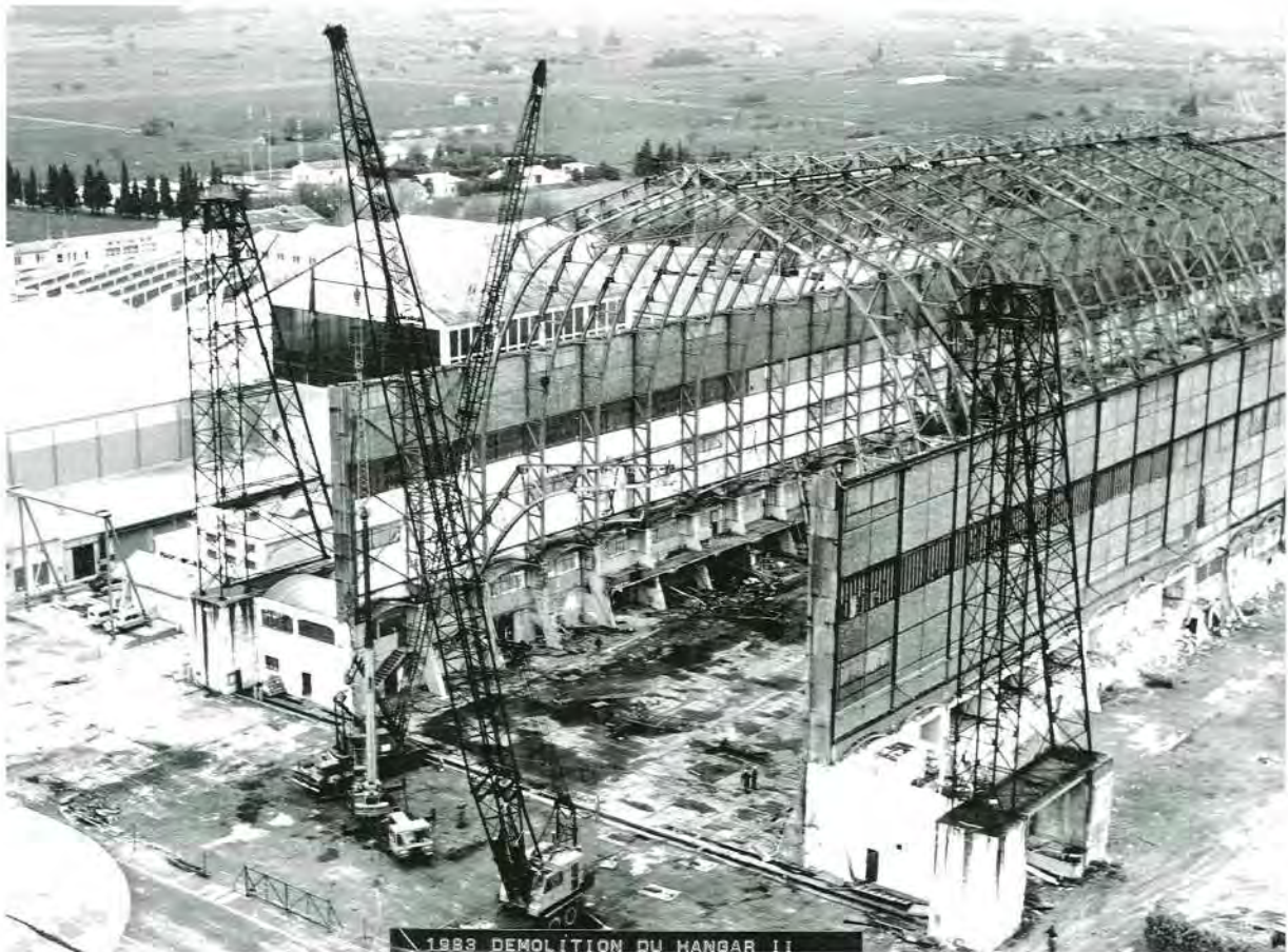
Démolition du Hangar II... avant la nuit de mistral fatidique (1983)
