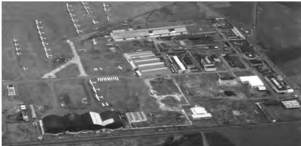
L'AIA en 1950 après les premières reconstructions
